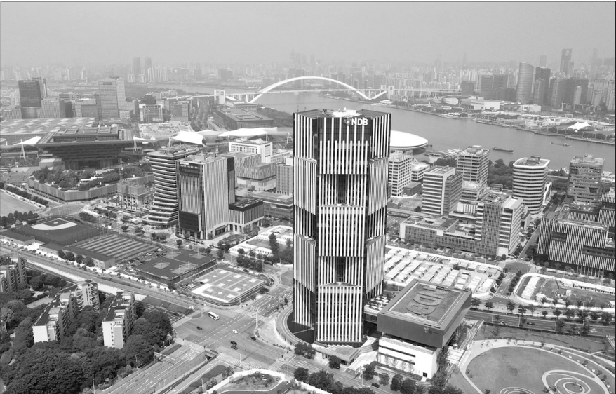
صورة ملتقطة جواً بواسطة طائرة مسيرة في ١٧ يونيو ٢٠٢٢ تُظهر مبنى المقر الرئيسي للبنك الجديد للتنمية التابع لتجمع بريكس في شانغهاي بشرق الصين (شينخوا)
